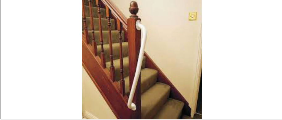
Resim 3. Merdiven trabzanında tutacaklar.
