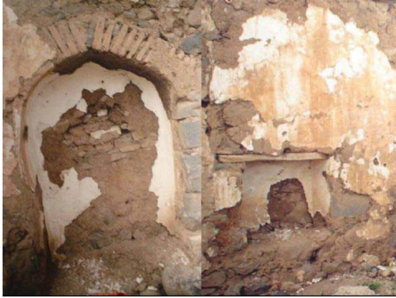
Eski evlerdeki asbest siva kalıntıları (Eşref Atabey Arşivinden)(39).
